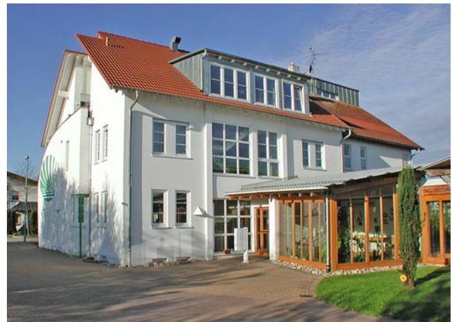
Abb. 1 ▶ Probewohnungen im DGM-Beratungsgebäude (Freiburg)
